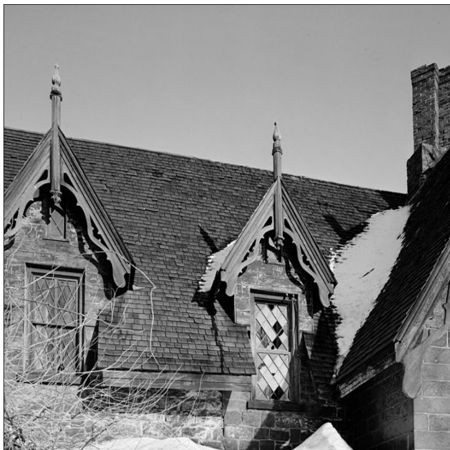
HABS NJ,2-HOHO,1-. Jack E. Boucher, 1971.
