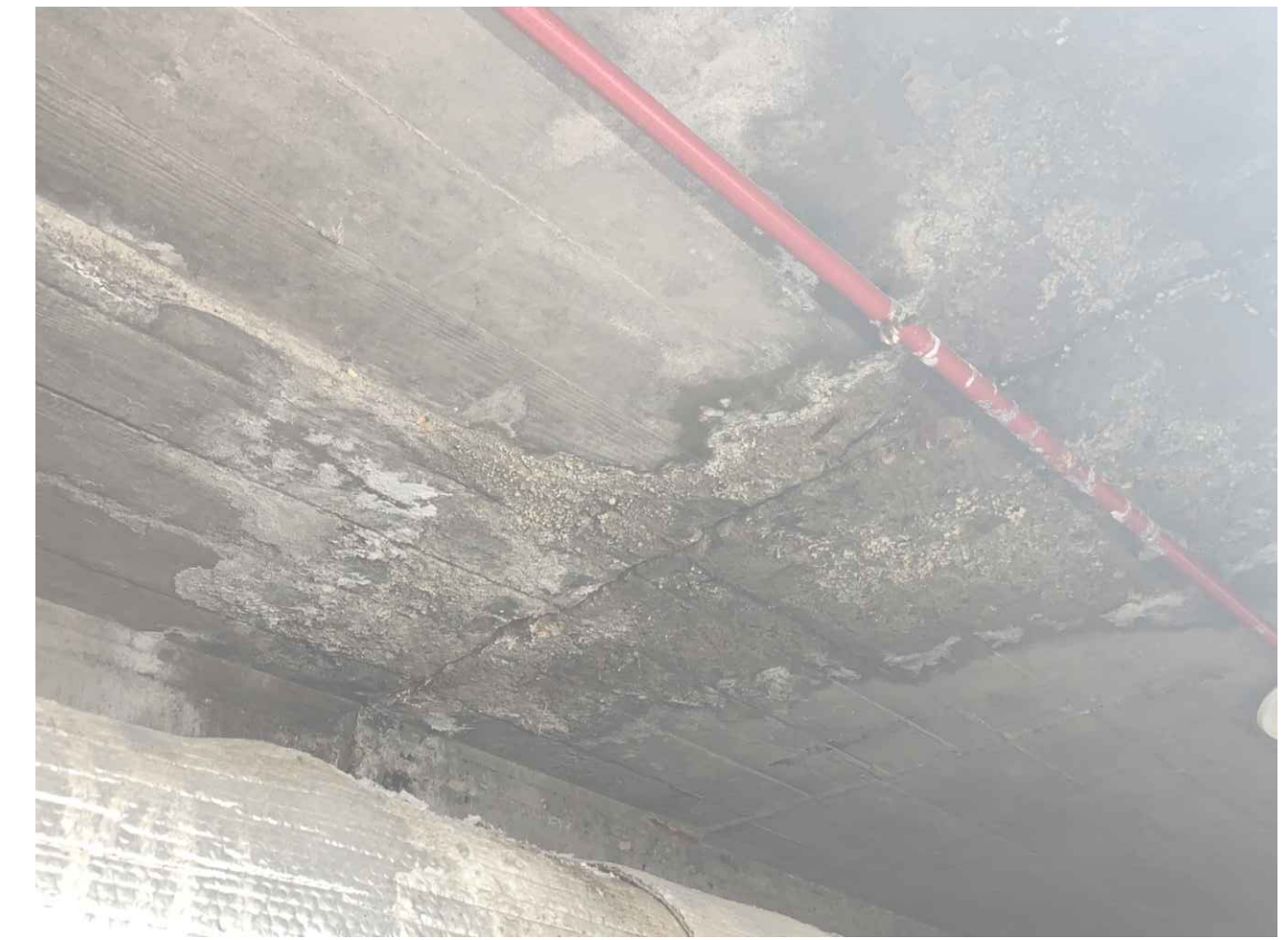
11 STA: 5+58 TUNNEL LID
