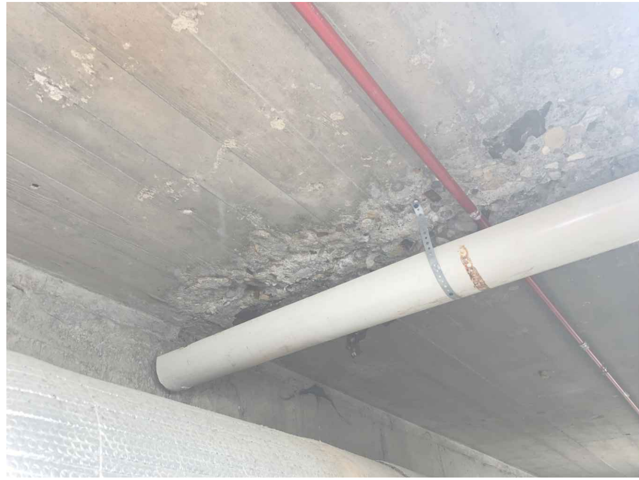
1 STA: 6+59 TUNNEL LID
