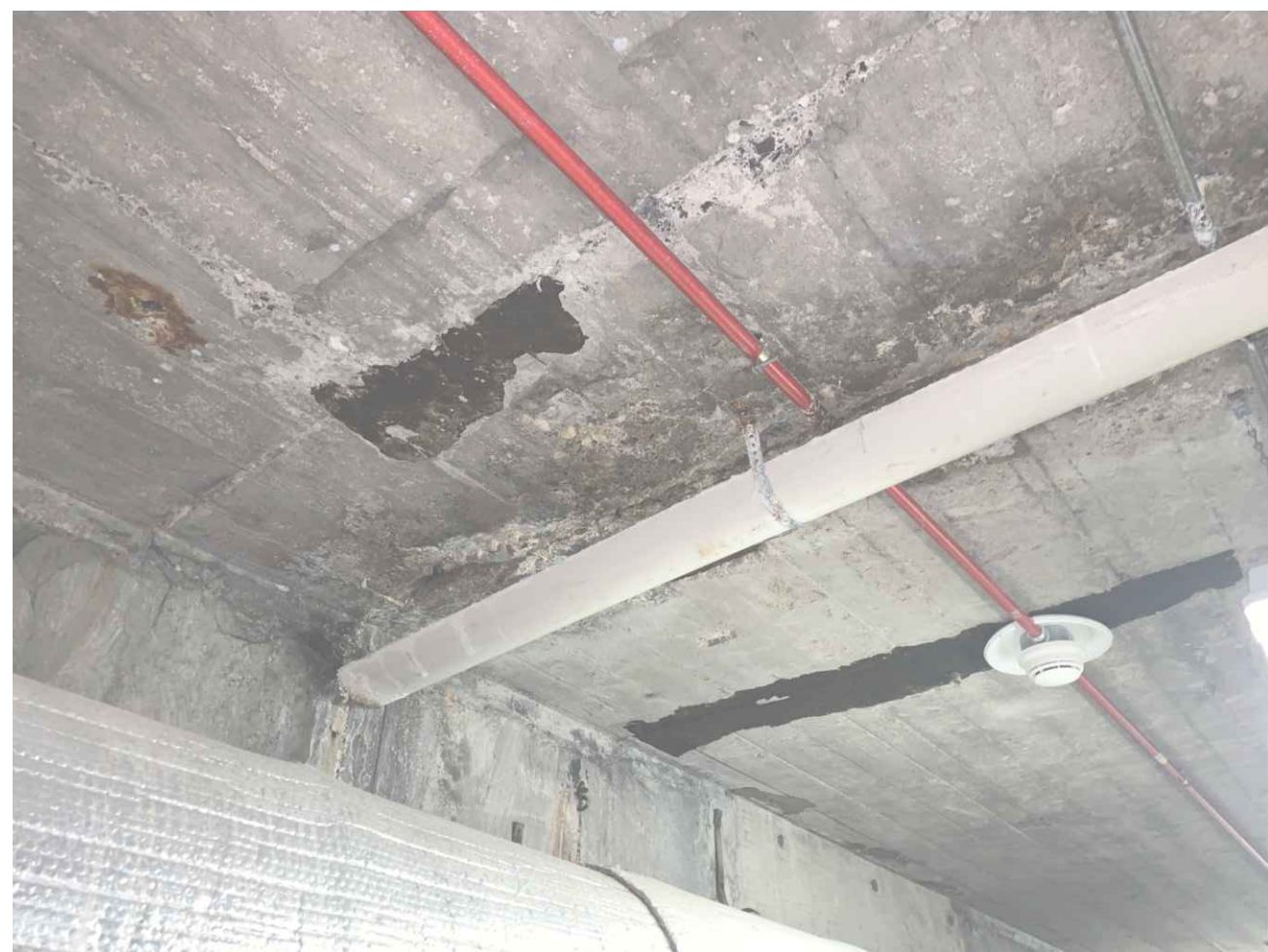
2 STA: 7+08 TUNNEL LID
