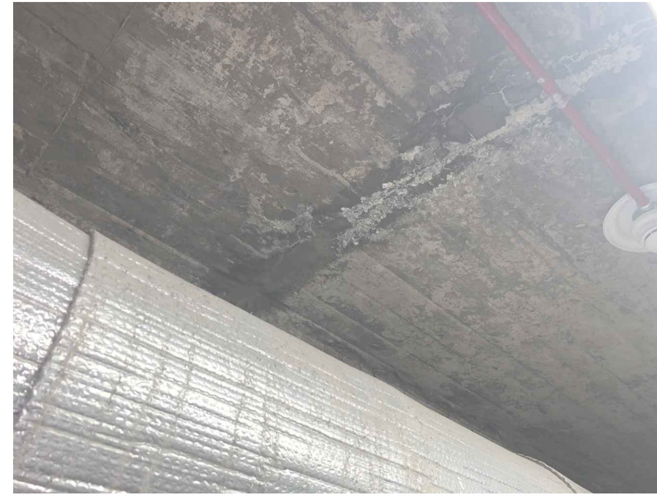
7 STA: 3+57 TUNNEL LID
