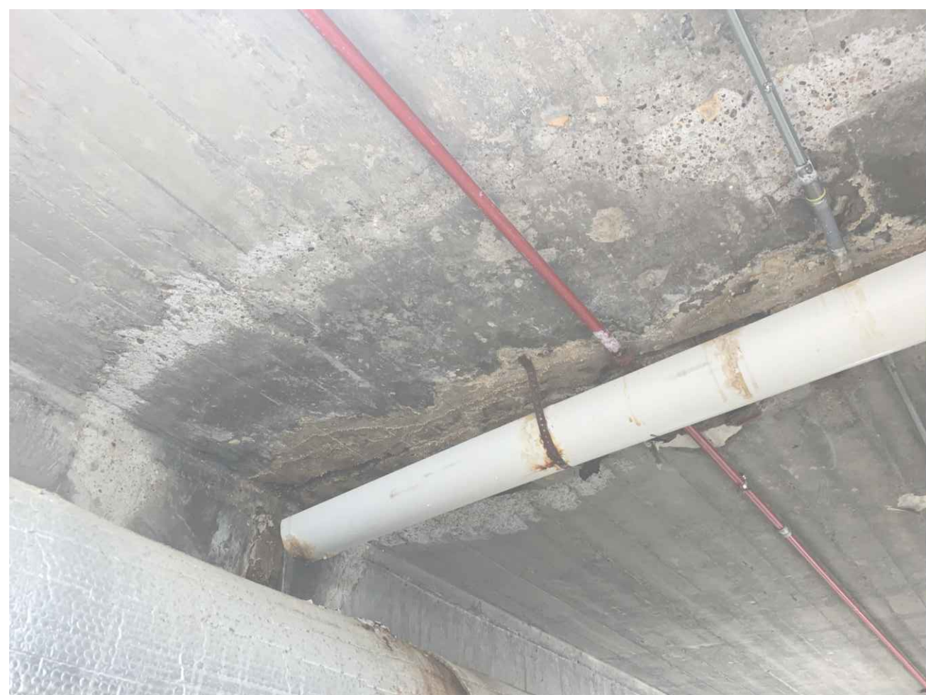
3 STA: 7+59 TUNNEL LID
