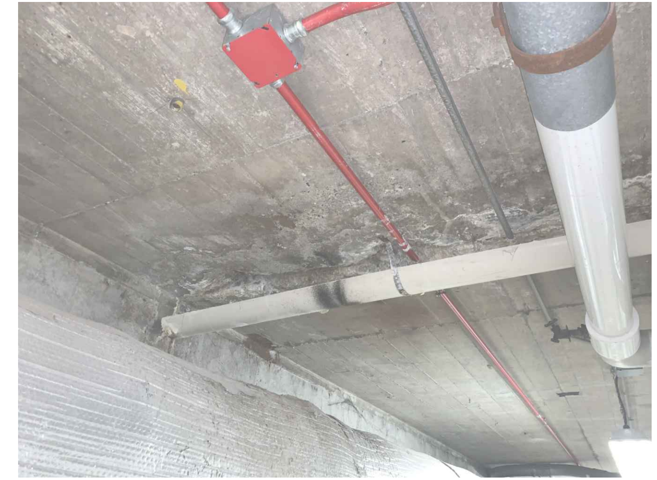
10 STA: 5+09 TUNNEL LID
