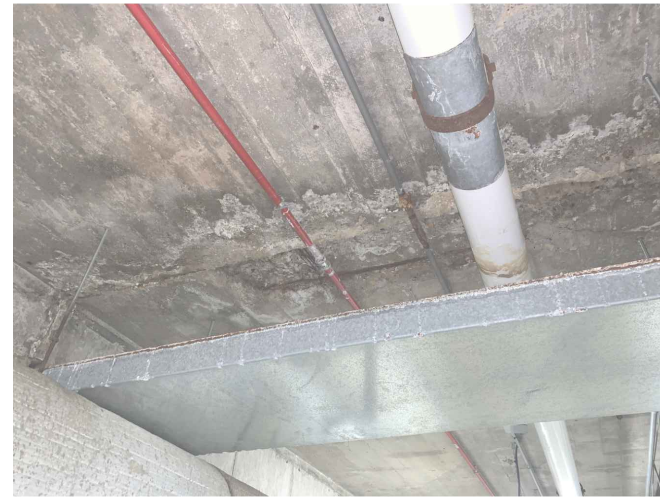
8 STA: 4+09 TUNNEL LID
