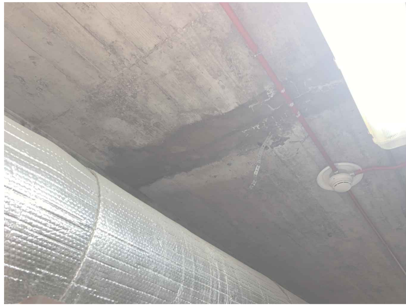
2 STA: 1+07 TUNNEL LID
