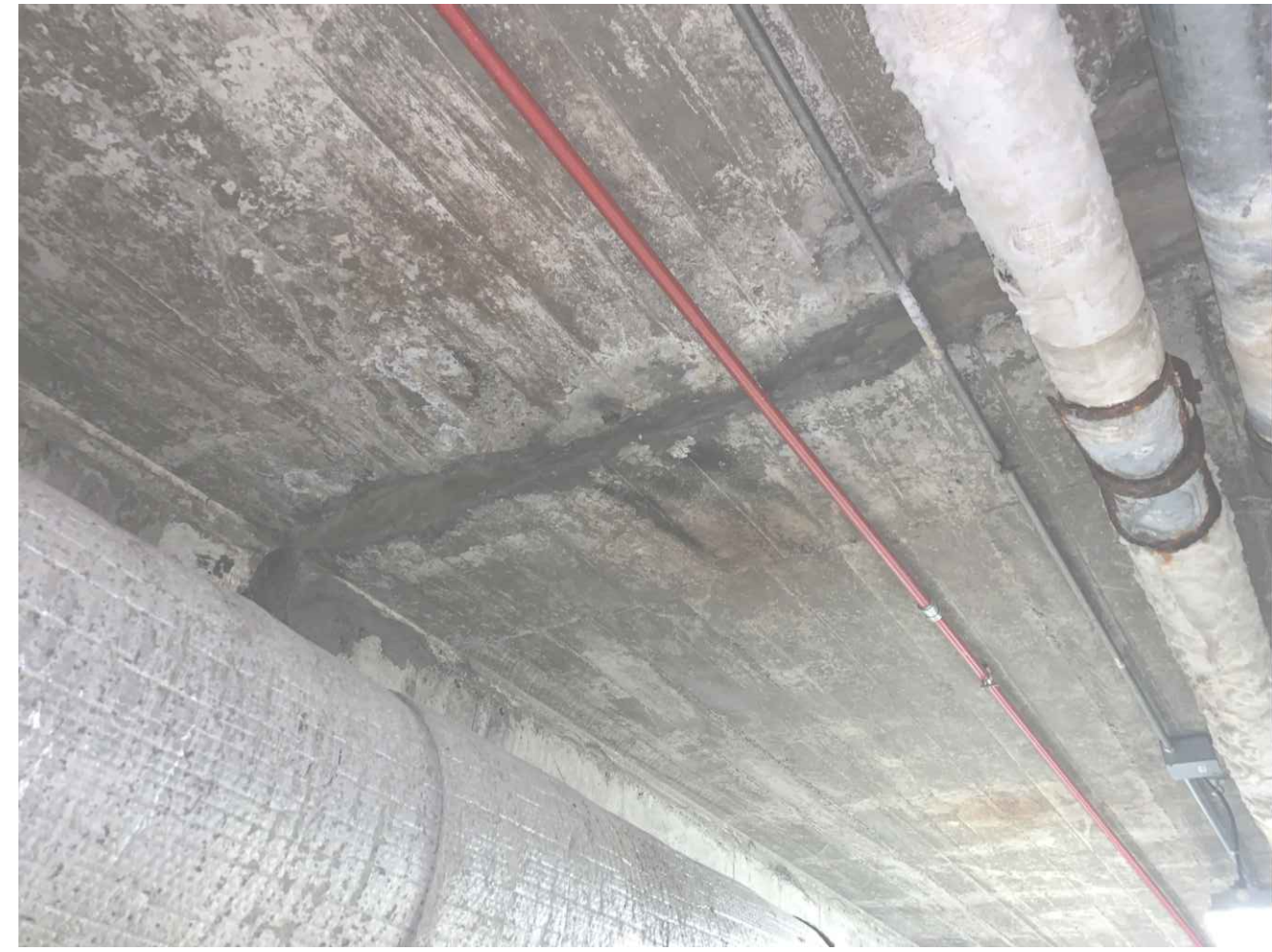
4 STA: 2+07 TUNNEL LID
