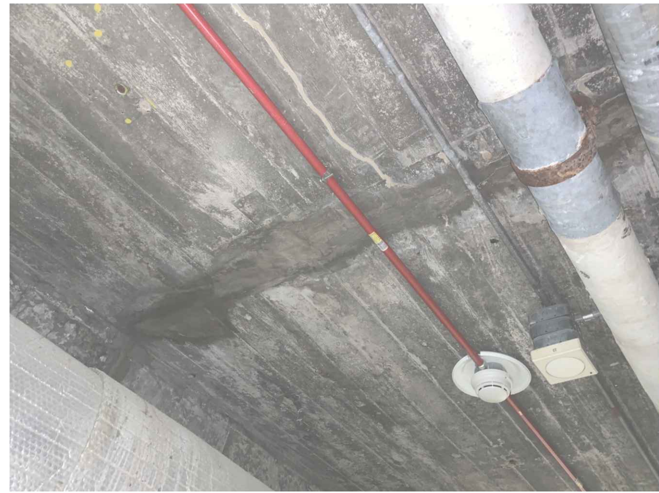
5 STA: 2+57 TUNNEL LID
