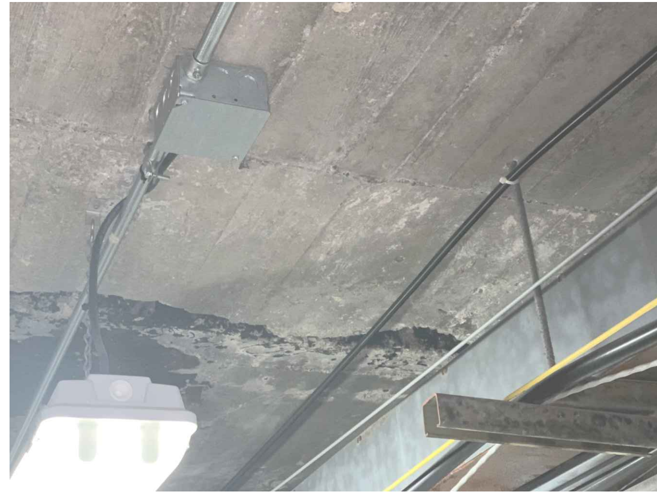
4 STA: 8+09 TUNNEL LID
