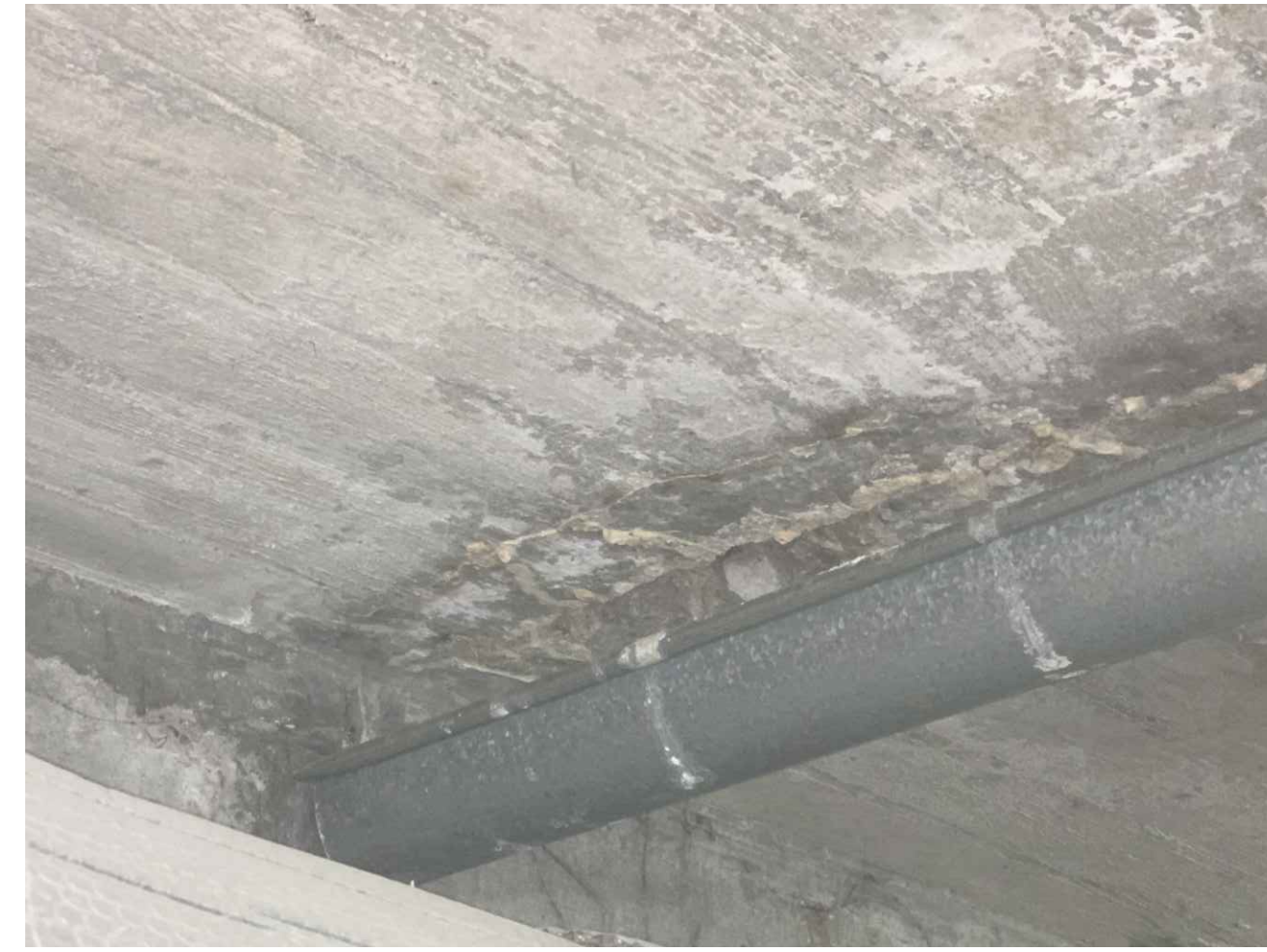
7 STA: 9+59 TUNNEL LID
