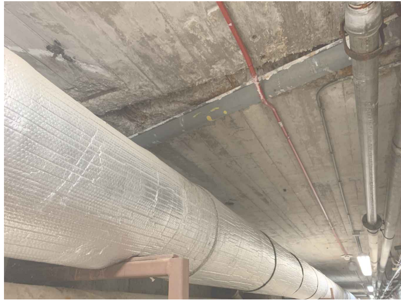
1 STA: 0+58 TUNNEL LID
