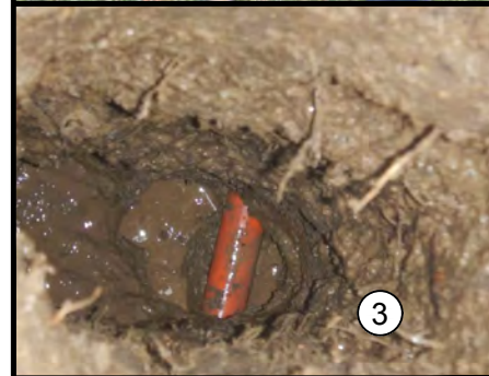
HH4 - ICN STA. 31+53
