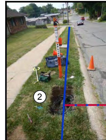
NE CORNER OF B AVE E & N. 11TH ST
