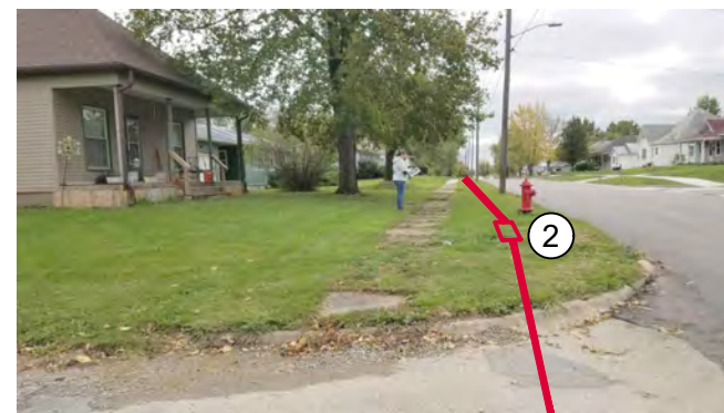
HH12 - ICN STA. 121+96
