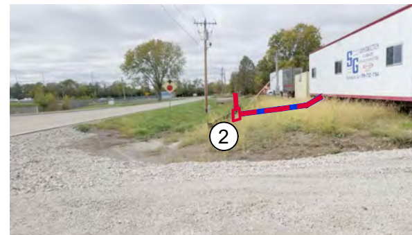
HH16 - ICN STA. 164+94
